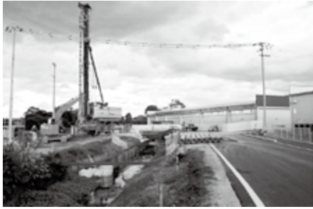
▲堀越東線道路改良事業
