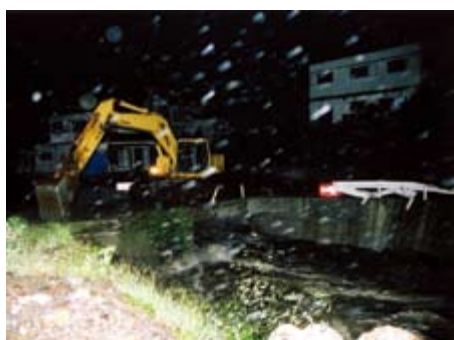
▲河川閉塞による被害を防ぐため、土砂の排出は深夜も続けられました。
