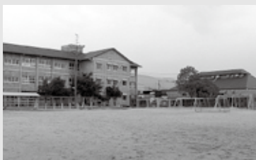
神拝小学校校舎建設事業
