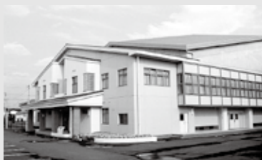
小松中学校体育館建設事業
