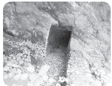
劈巖透水路4番隧道入口(丹原町来見地区)
