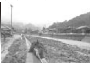
市道川崎線災害復旧工事 市工事（小松町妙口）
