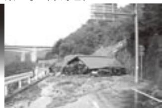
県道西条久万線災害復旧工事 県工事（中野乙）
