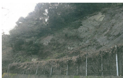
<切土法面：コンクリート吹付>
