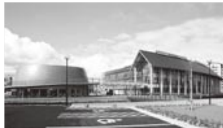
▲総合福祉センター（平成16年10月12日完成）
