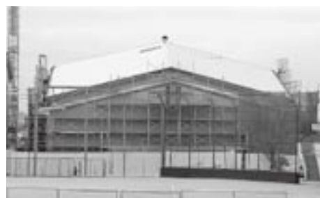
▲小松中学校体育館（整備中）
