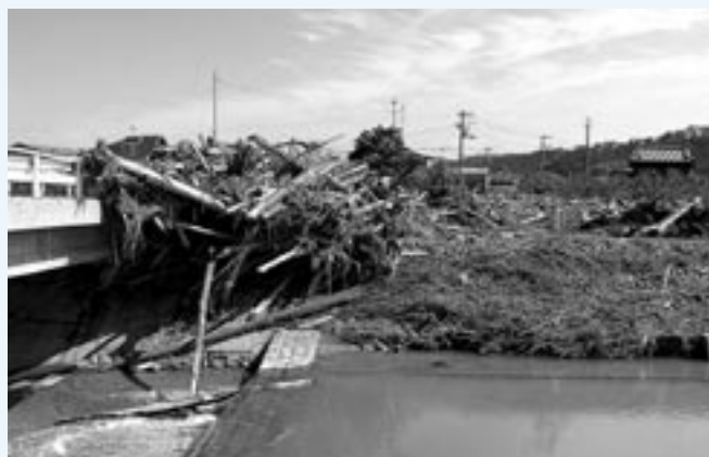
▲小松町妙口下地区の妙の谷川沿いに、ひっかった流木〔旧小松町〕
