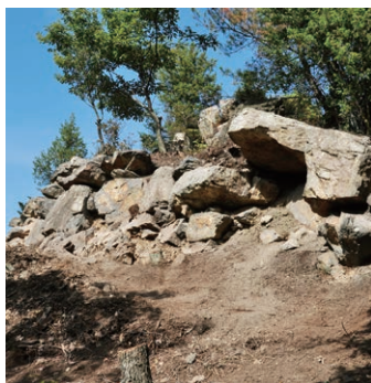
▲西部頂上付近の石積み城壁
