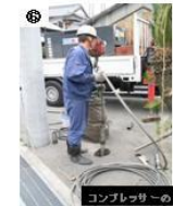
コンプレッサーのホースを挿入
