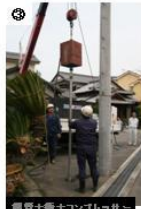
鋼管+ポンプ+コンプレッサー
