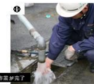
洗浄作業が完了
