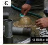
洗浄用の鋼管に交換する
