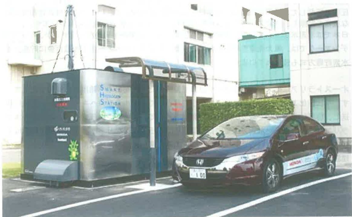
ホンダ小型燃料電池ステーション。2.4m×3.2mと狭い土地に適している。9kgの水と8kwhの電力で35MPa(メガパスカル)の水素を1kg製造できる。
