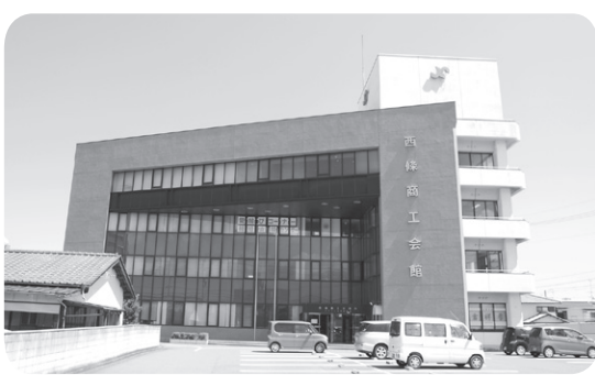
津波避難ビルに指定されている西条商工会館
