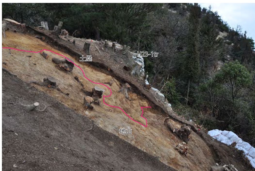
H27-1 トレンチ完掘状況 (南から)
