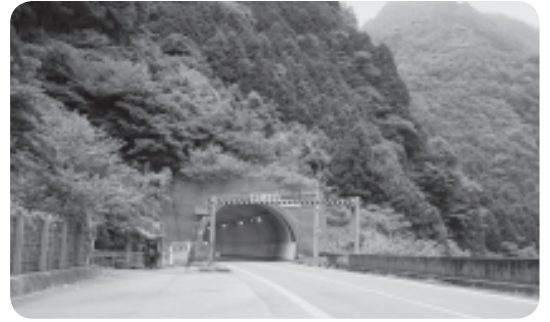
寒風山トンネル(愛媛県側)
