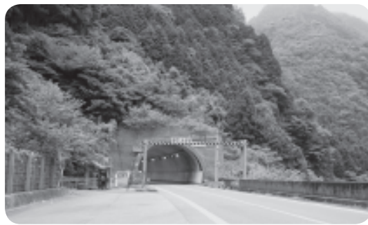
寒風山トンネル（愛媛県側）
