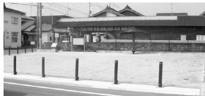
▲完成したお祭り広場
