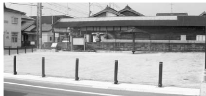
▲完成したお祭り広場
