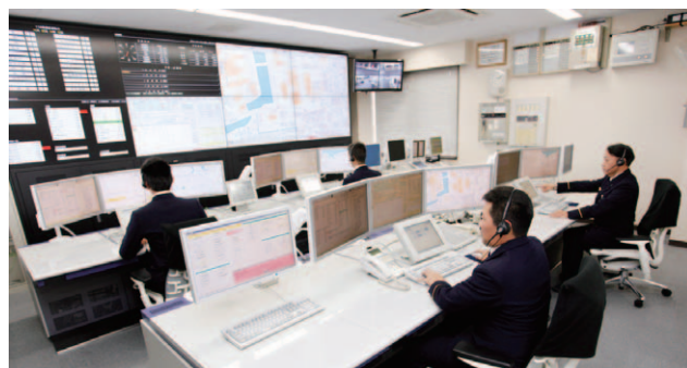
▲高機能消防指令センター (消防本部3階)
