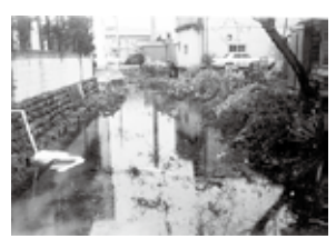
下水道整備前
