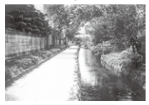
下水道整備後
