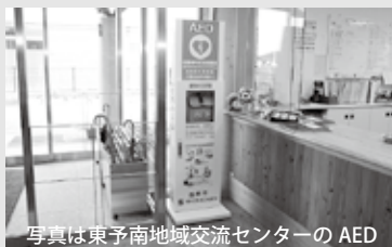
AED設置事業 写真は東予南地域交流センターのAED
