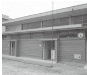
▲飯岡小学校屋外トイレ
