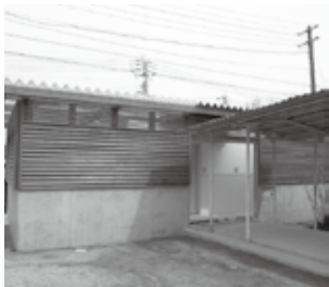
▲神拝小学校屋外トイレ
