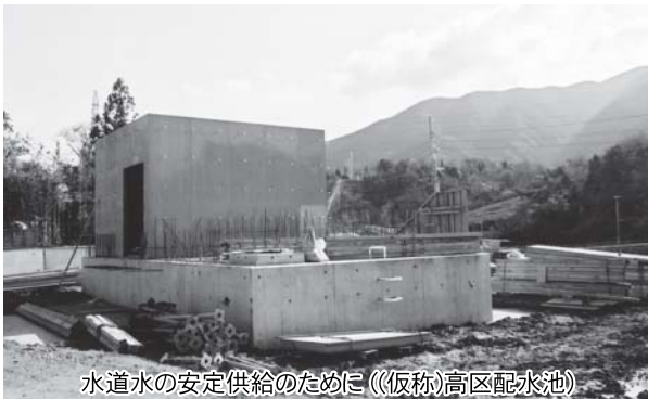
水道水の安定供給のために(仮称)高区配水池
