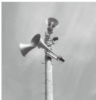
▲整備された野口連合自治会放送塔
