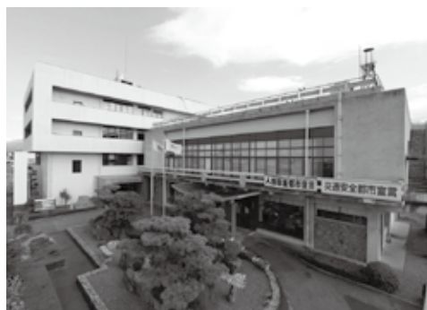
▲本年度から改修予定の小松総合支所 手前の別館は、奥側の本館改修が終了後に、 取り壊し、駐車場にする予定です。
