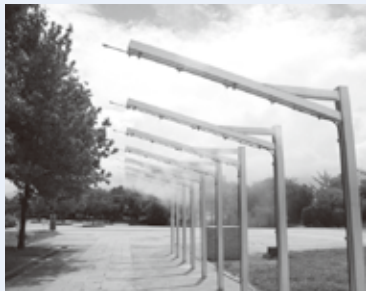
▲西条運動公園に設置された固定式の ミストシャワー
