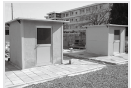
夏季の試験データでは、屋根部分において従来品に比べ10℃以上の遮熱効果を記録した性能検証施設
