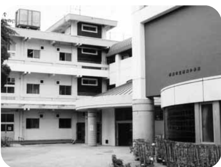
耐震改修実施済の校舎(西条小学校)
