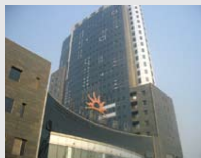
▲外壁に太陽光電池をつけた電谷錦江国際ホテル
