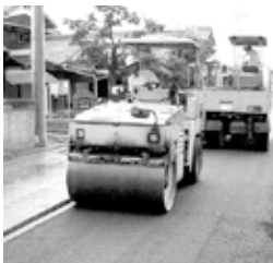
▲溶融スラグ製品を活用したアスファルト舗装工
