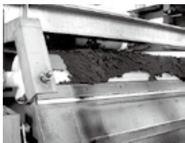
▲汚泥脱水の状況
