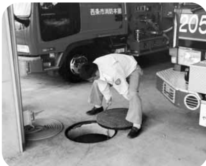
西消防署内の地下にある雨水タンク
