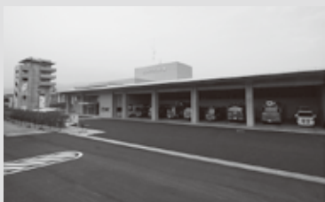
西消防署庁舎建設事業
