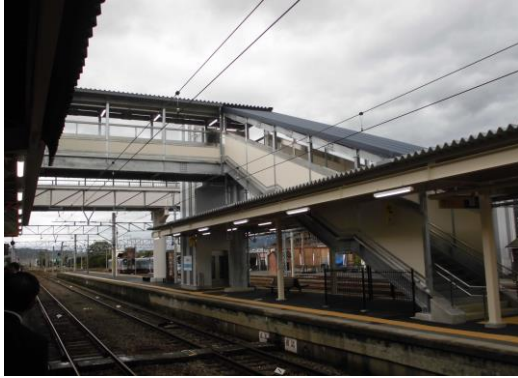
こ線橋・内方線付き点状ブロック
