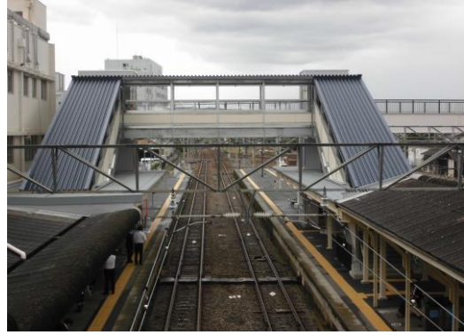
こ線橋・内方線付き点状ブロック
