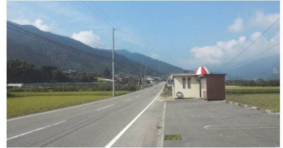
国道11号(中川地区付近)
