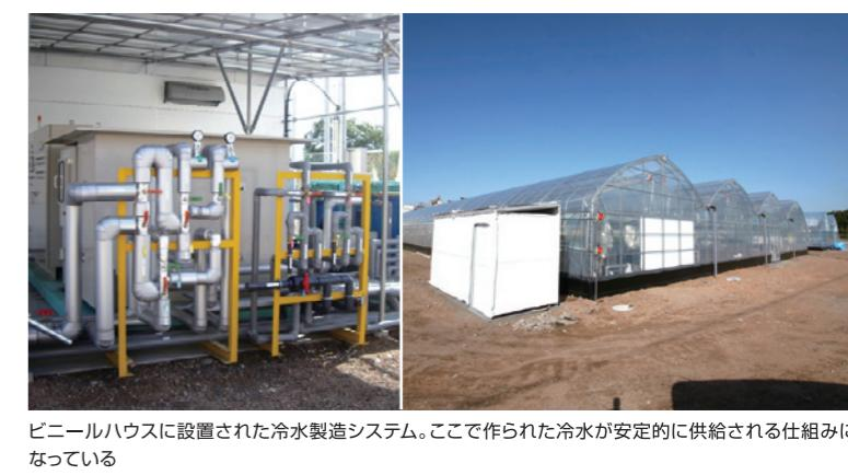
ビニールハウスに設置された冷水製造システム。ここで作られた冷水が安定的に供給される仕組みになっている
