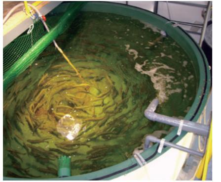
火力発電所の排熱と地下水を利用した冷水製造システムを用いて、サツキマスの陸上養殖を行っている
